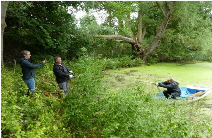
Abb.2 Sorge auch für Heiterkeit: Verlegen der DRAUSY-Schläuche im Dorfteich Trent
