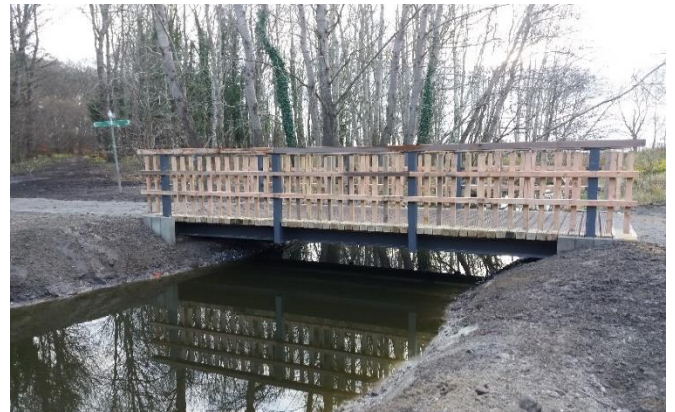
Abb.4 Ufer noch kahl: Neubau mit großem Durchlass
